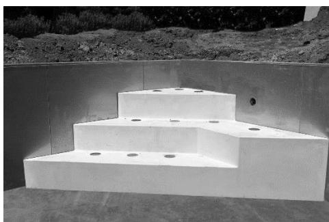
Figura 4 – Scala sotto liner stabilizzata.
